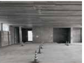
1階足場解体後**
