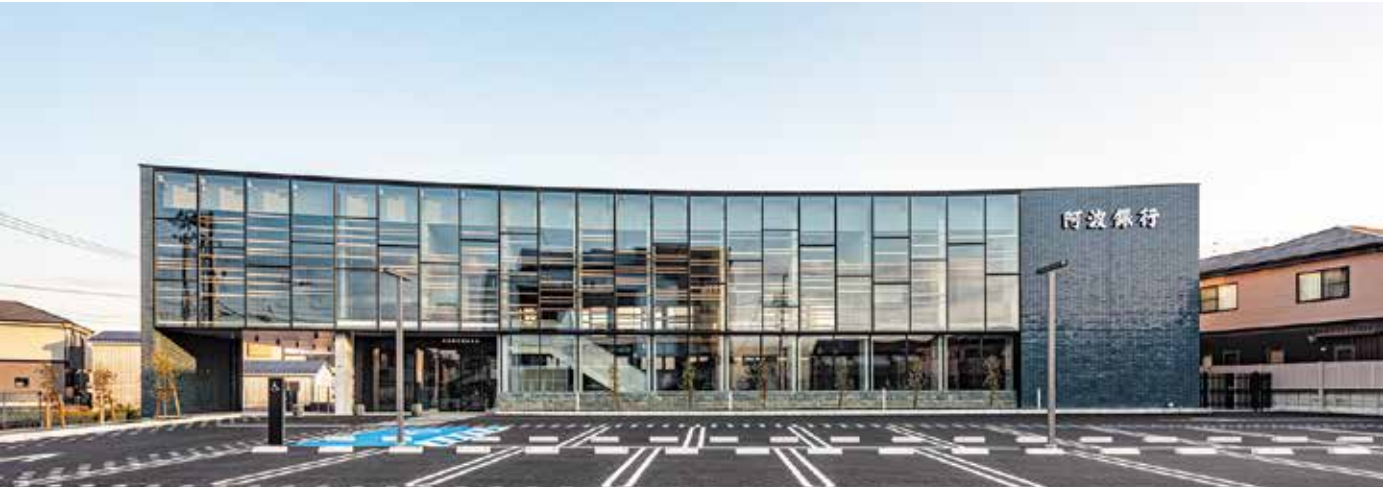
北側外観。耐力壁のない透明感のあるファサード。*
