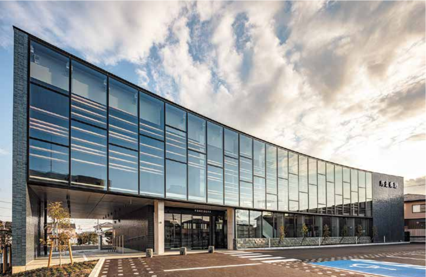
北側外観。内部の木ルーバーと無目がリズミカルに変化する。*
