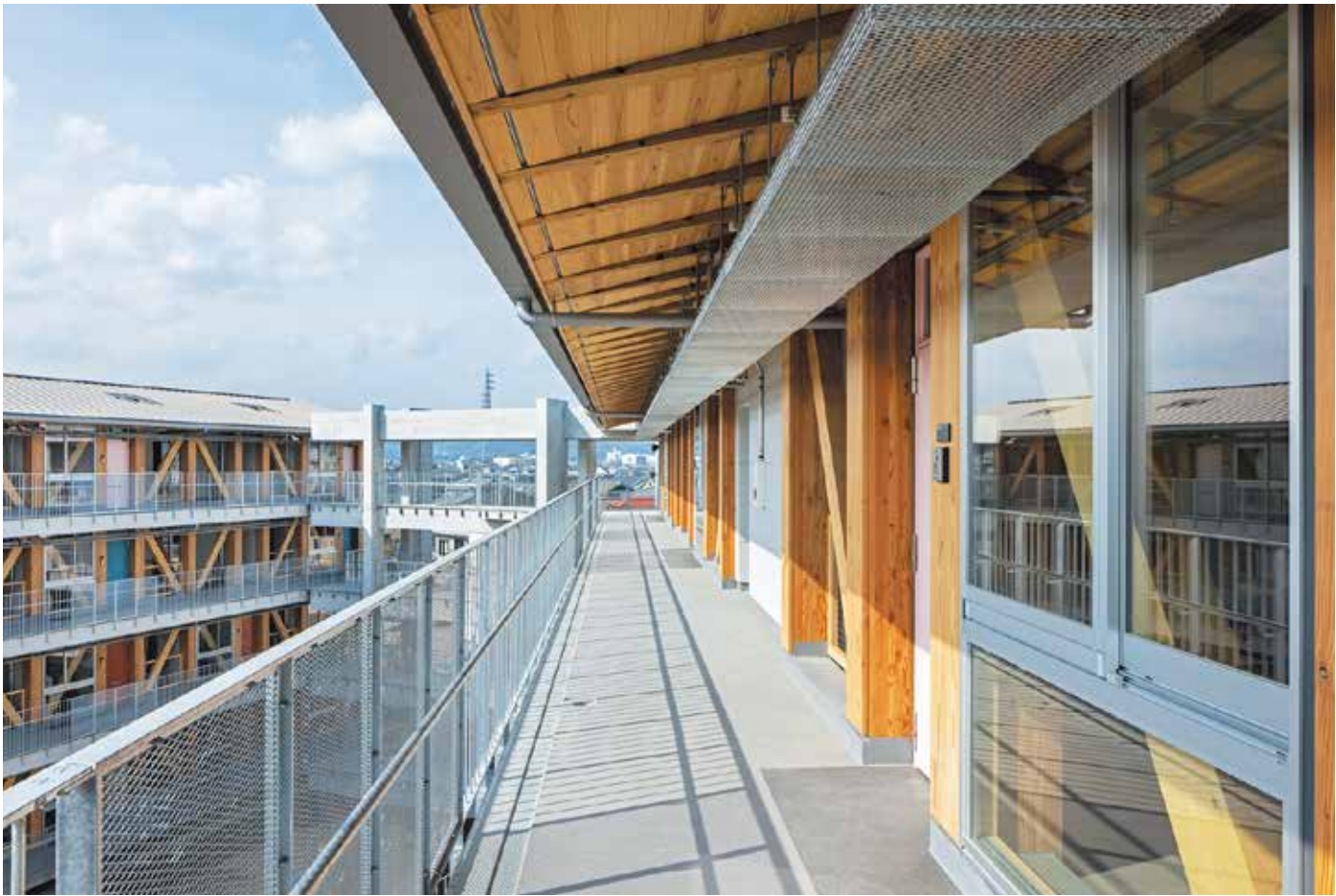
木造で1800mmはね出した4階共用廊下。軒裏の垂木と野地板は現しとし、県産杉を使用した。軒下に吊られているエキスパンドメタルは、設備やスプリンクラーの配管の目隠し。
