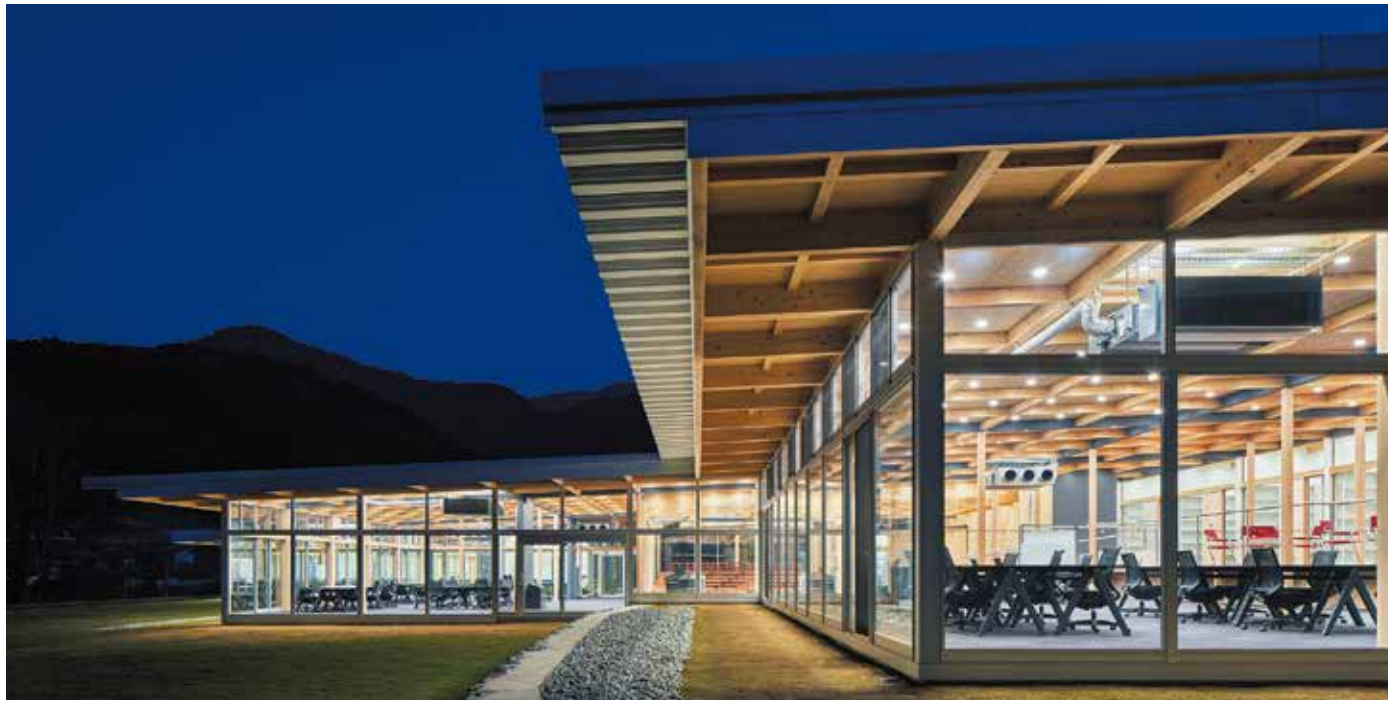
研究棟の軒下空間
