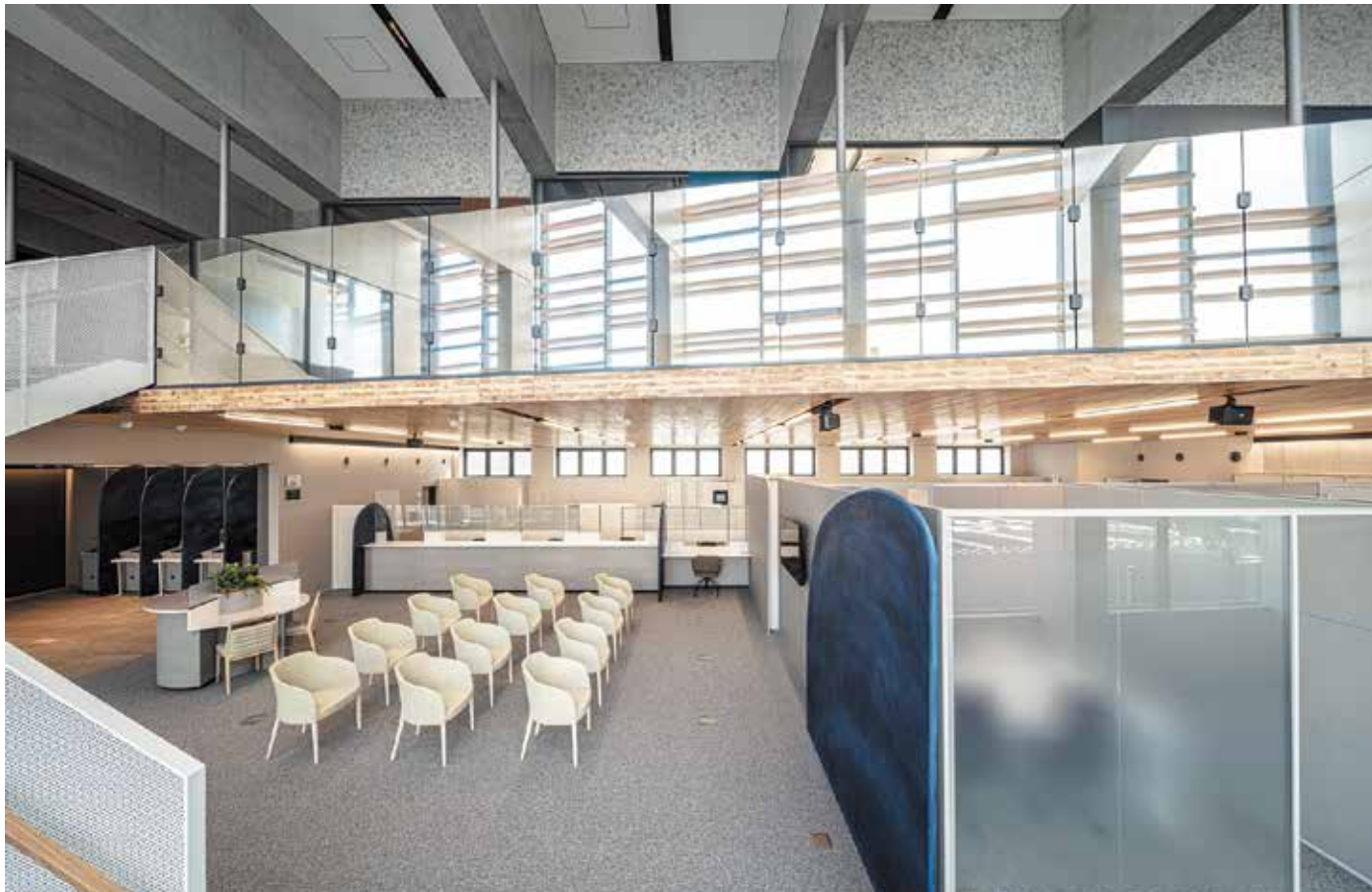
1階ロビー。天井CLTが吊り下げられている。*
