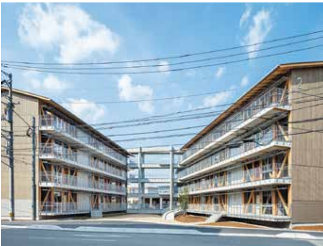
東より見る。中庭を挟んで向かい合い、見守りあうような2棟の配置。妻面の外壁は県産杉堅張り。
