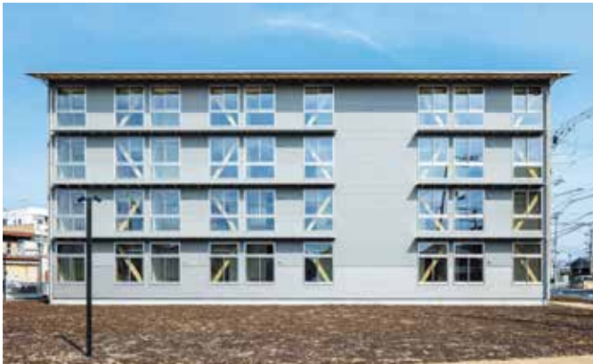
南棟南外観。室内に現されているプレースの様子がわかる。
