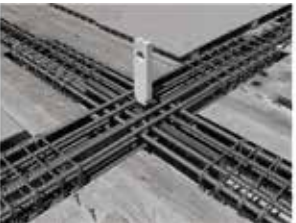
柱脚金物設置時、打設前**
