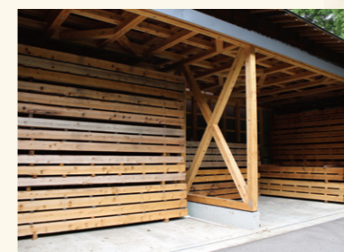
美波町と提携し、災害が発生した時に木材を使用できる備蓄庫もあります。
